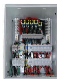
スマート接続箱(D C 開閉器) PV array combiner box
