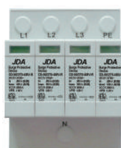
ACサージ吸収装置 Surge protective device AC
