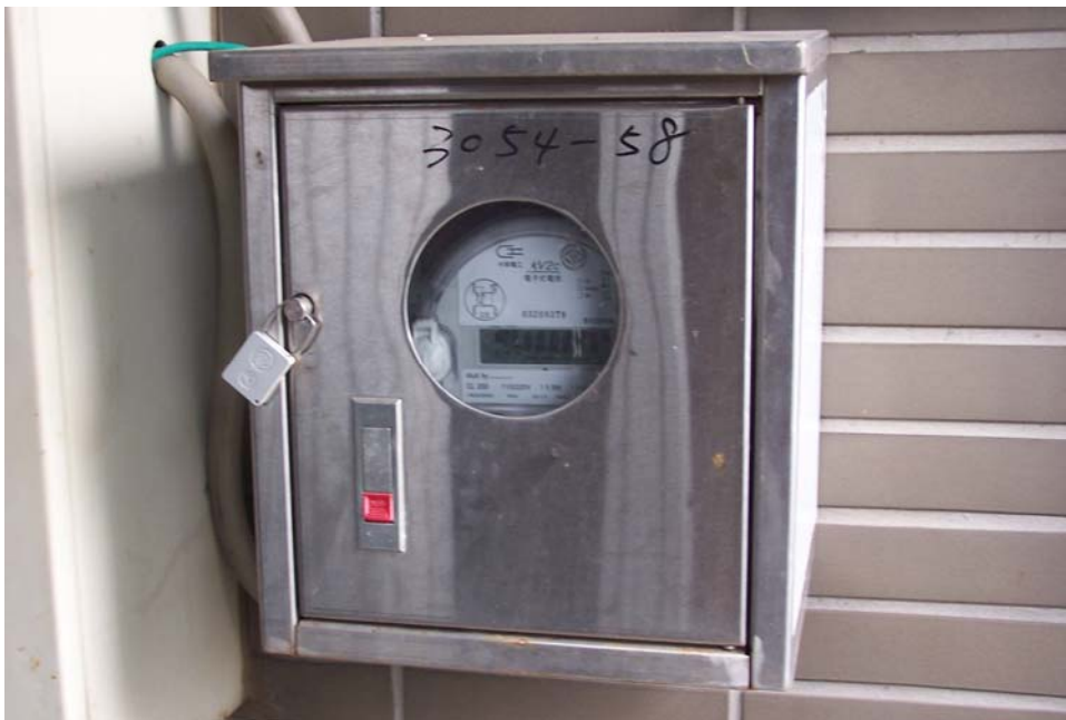
圖 9: 完成封印電度表箱
